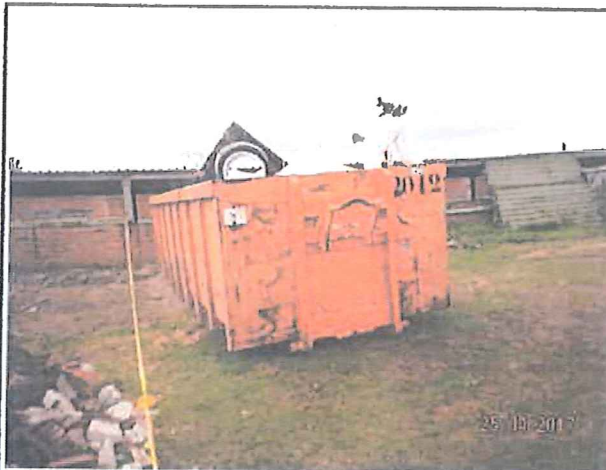
Foto 22. D.a.v is de ventilatie kap in de container aan het stoppen
