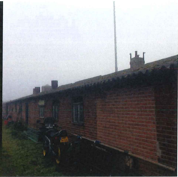
foto 7 golfplaat met vormstuk, gelijktijdig met Bron B03 saneren
