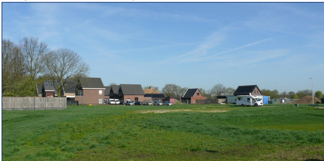
Woningbouwlocatie Heusden Oost 1 e fase in aanbouw
