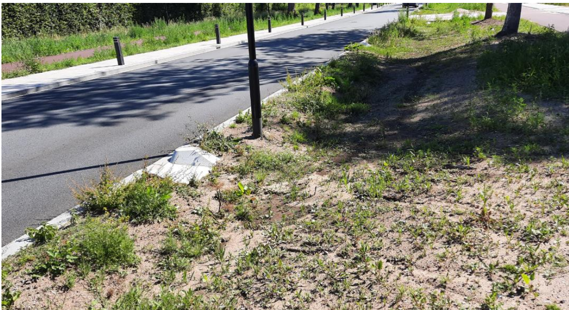
Figuur 13: Voorbeeld infiltratielaagte waar het water vanaf het wegdek invloeit
