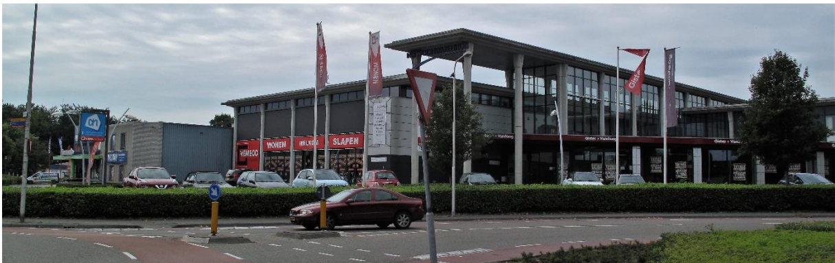
Figuur 1. Boven: Luchtfoto bestaande situatie, met rechts de rotonde Industrielaan (naar links) en de Prins Bernhardstraat (naar midden onder) [1c: p. 9]. Onder: De projectlocatie aan de Industrielaan (rechts) – Prins Bernhardstraat (links), gezien vanaf de rotonde
