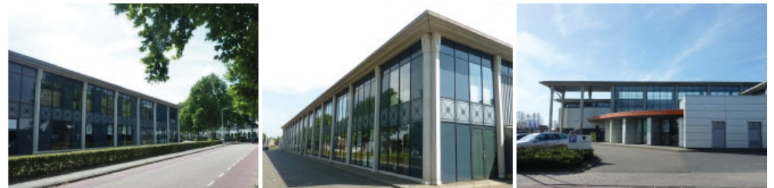
Huidige gevel aan de Industrielaan en de entree aan de rotonde (foto rechts).
