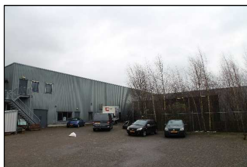
Foto 3. Achterzijde bedrijfspanden met richting het noordoosten gezien vanaf midden plangebied
