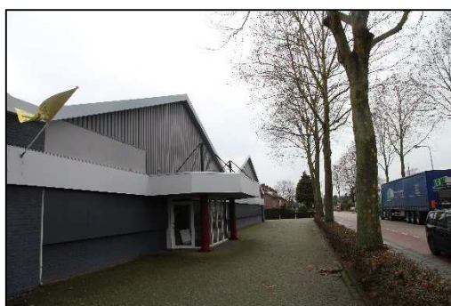
Foto 1. Loods in noordwesten van plangebied, grenzend aan de Industrielaan
