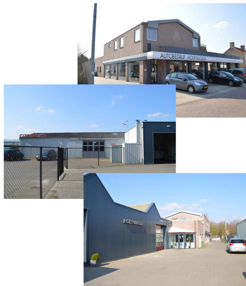
Figuur: foto's bestaande situatie
