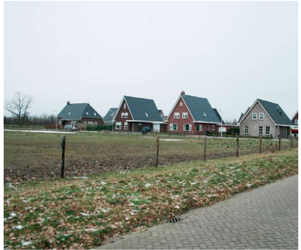
nieuwbouw aan de Hanegraaffweg
