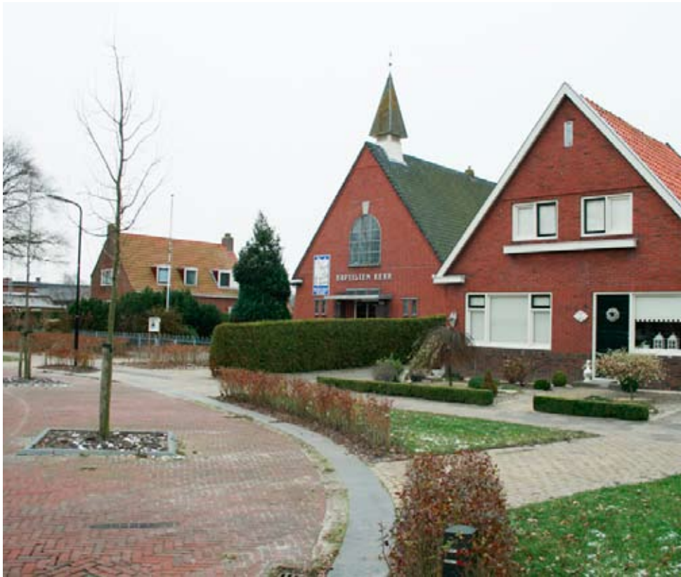
Baptistenkerk aan de Zevenhuisterweg
