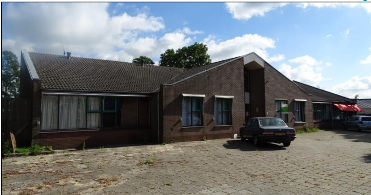
Figuur 2.2. Vooraanzicht van de bebouwing, gezien vanuit zuidwestelijke richting.
