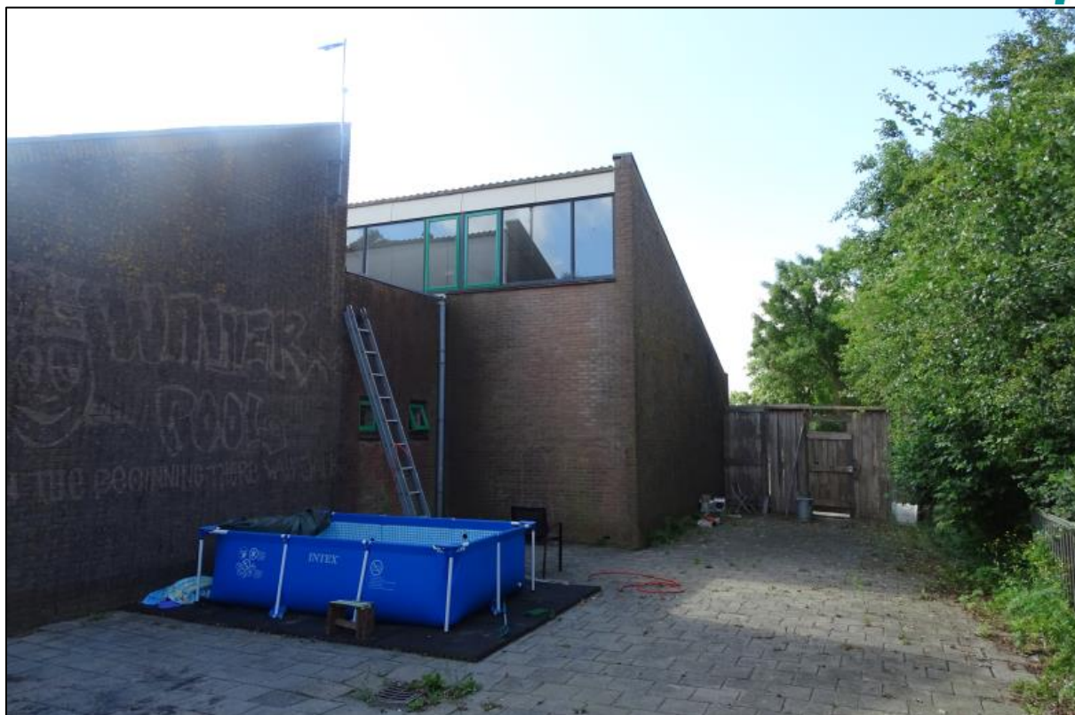
Figuur 2.4. Achter- en zijaanzicht van de bebouwing, gezien vanuit noordwestelijke richting.
