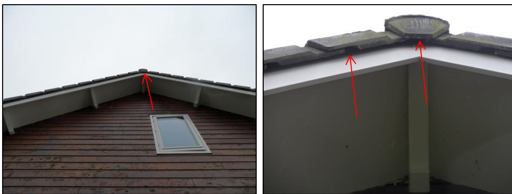
Detailfoto's van de woning op het Achterbos 36 R-20. Onder de nok is genoeg ruimte voor een gierzwaluw. Een nestplaats van een gierzwaluw is om die reden niet in dit woonhuis uit te sluiten.
