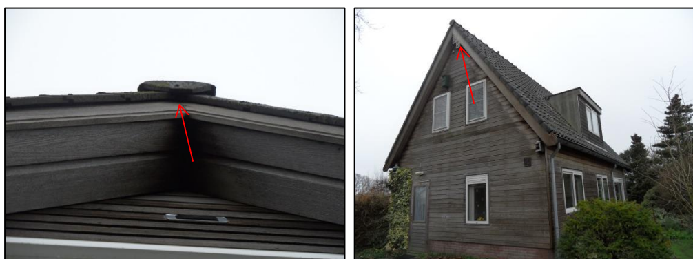
Detailfoto's van de woning op het Achterbos 32 R-1. Onder de nok is genoeg ruimte voor een gierzwaluw. Ook hangen aan de noordoostgevel gierzwaluwnestkasten. Een nestplaats van een gierzwaluw is om die reden niet in dit woonhuis uit te sluiten.
