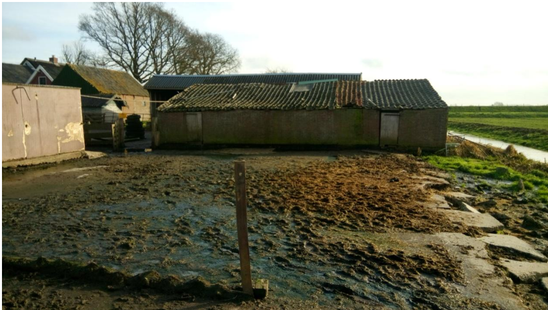
Betonverharding achter schuur
