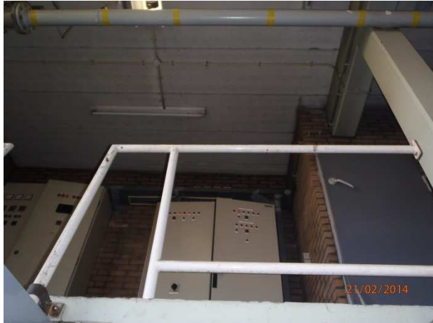
Afbeelding 8. De binnenzijde van het machinegebouw.
