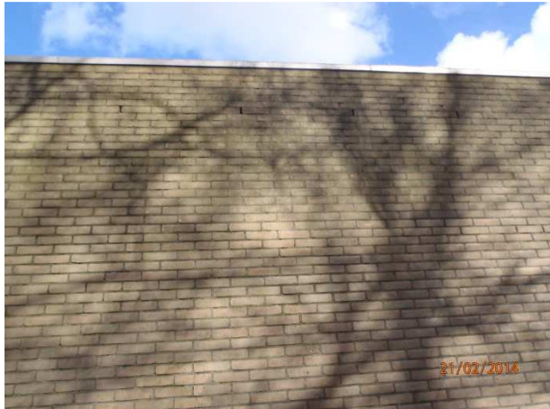
Afbeelding 9. Gevel met open stootvoegen
