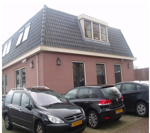
Foto 2-4: Achtergevel kantoorgebouw (blok B)
