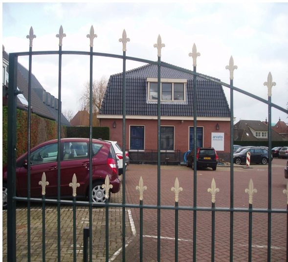
Foto 2-3: Voorgevel kantoorgebouw (blok B)
