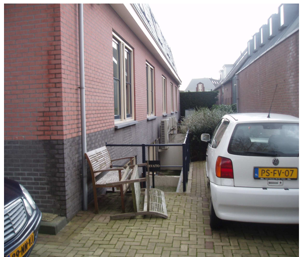
Foto 2-6: Zijgevel kantoorgebouw met koekoekconstructie (blok B)
