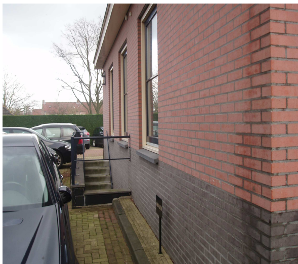
Foto 2-5: Achtergevel kantoorgebouw met trap naar de kelder (blok B)
