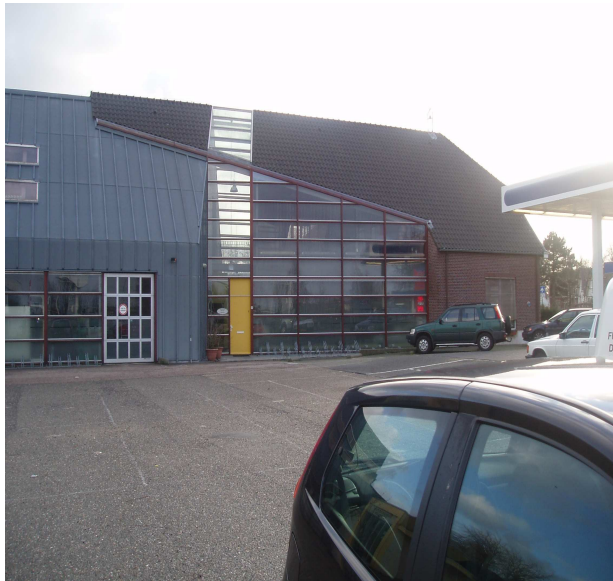
Foto 2-7: Zijgevel te slopen gebouw (blok C)
