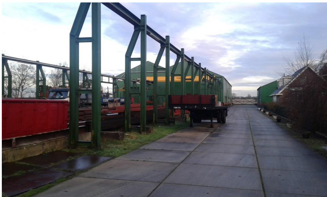
Foto 3: Zicht vanuit zuidoostzijde op locatie 'bouw overkapping'.
