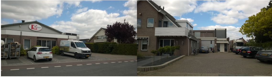
Afbeelding 4 het bedrijf vanaf de west- en de zuidzijde
