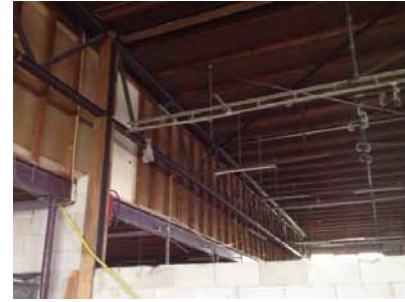
foto binnenzijde bedrijfshal
