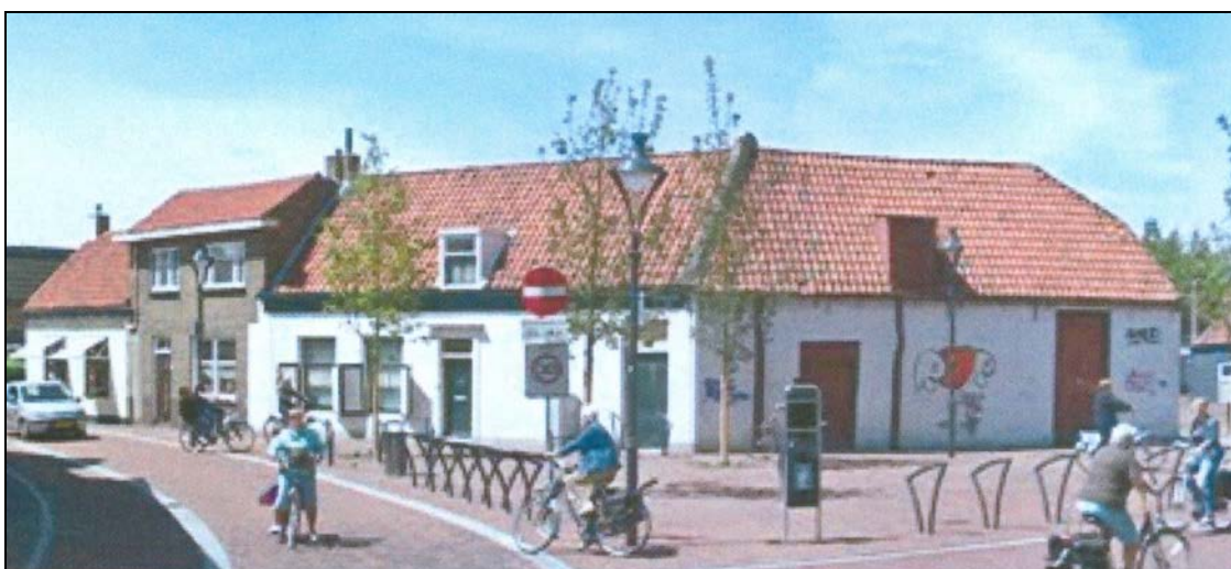
Afbeelding 4. De te slopen bebouwing: van links naar rechts: Rehobothstraat 2, Paspootstraat 4 en Paspootstraat 2). Bron: Google Maps, 2013.
