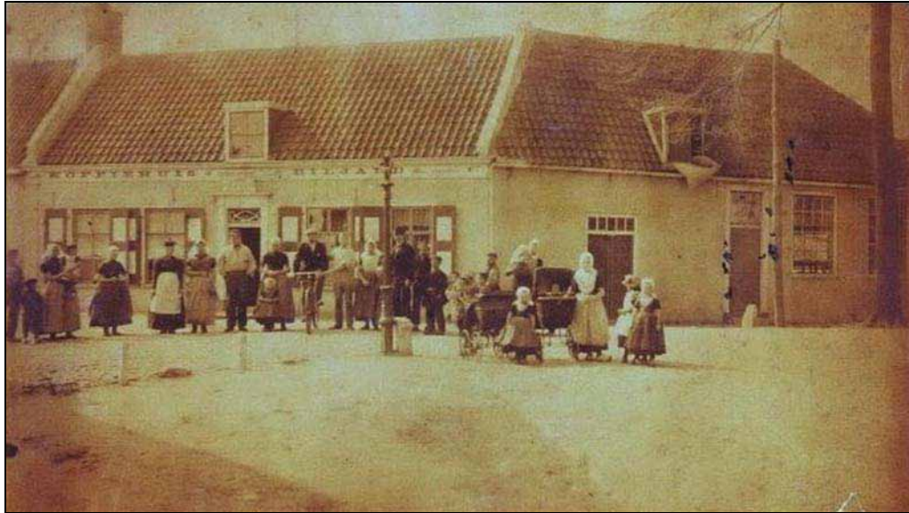
Afbeelding 12. Een foto van de straatzijde van de bebouwing ter plaatse van het onderzoeksgebied uit circa 1898. In deze periode was het pand in gebruik als koffiehuis met biljart. Bron: www.platformsouburg.nl/fotosite/1-Straten/Vroeger/Oost-Souburg/Paspoortstraat/slides/Paspoortstraat-002.html
