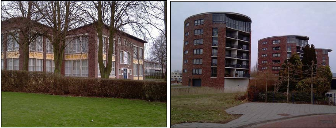
Afbeelding 3: Woningen en voorzieningen aan weerszijden van de Hercules Segherslaan.
