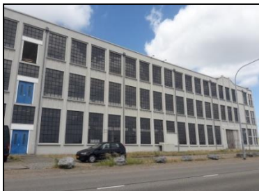
Figuur 3. Timmerfabriek ten noorden van de onderzoekslocatie.
