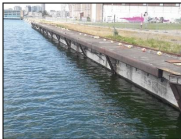
Figuur 4. Kade ten zuiden van de onderzoekslocatie.
