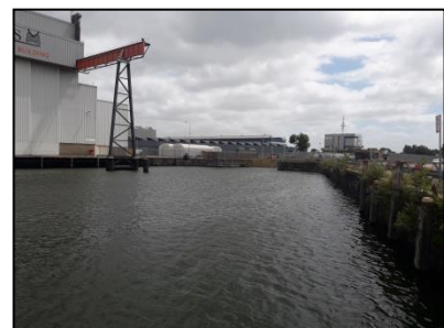
Figuur 8. Zicht op de onderste havenarm in zuidelijke richting.
