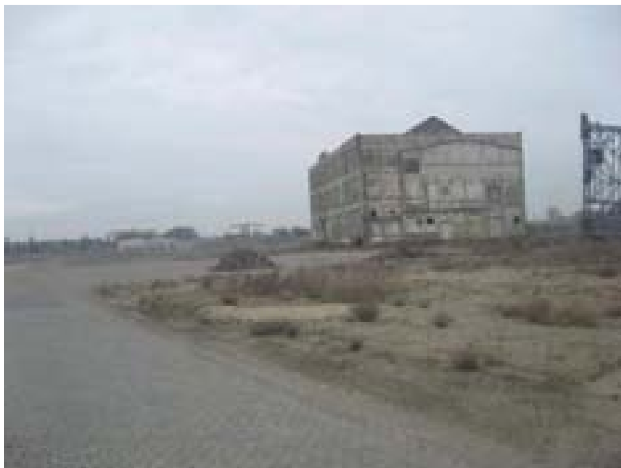
nog aanwezige loods op de locatie
