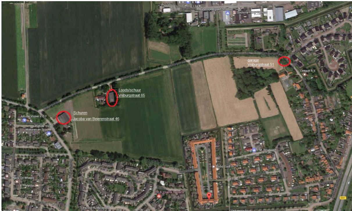
Afbeelding 4.25 Te slopen opstallen (schuren Jacoba van Beierenstraat 46, Gemeente lood/schuur Vrijburgstraat 65 en garage Vrijburgstraat 51)
