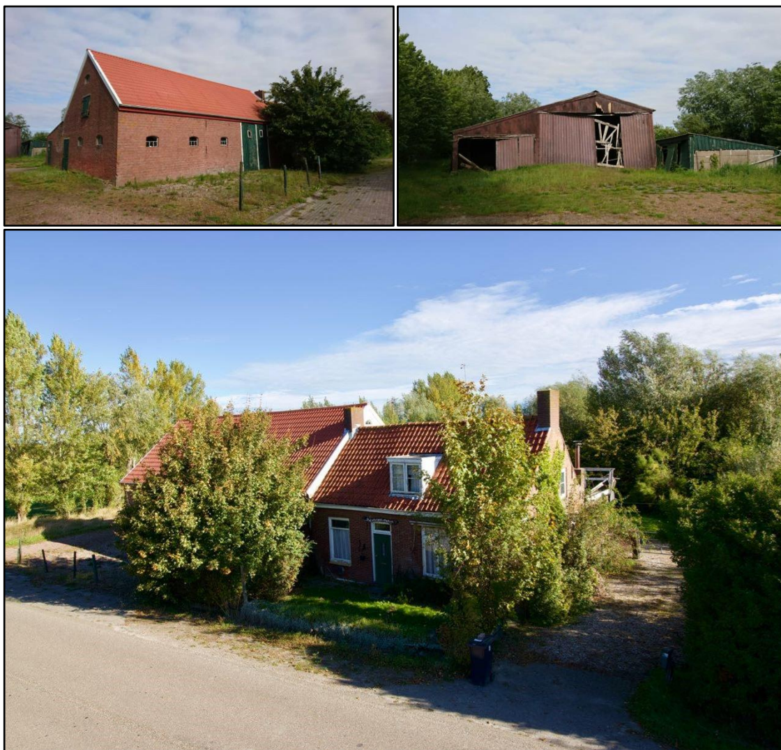
Figuur 3: Foto's bestaande situatie
