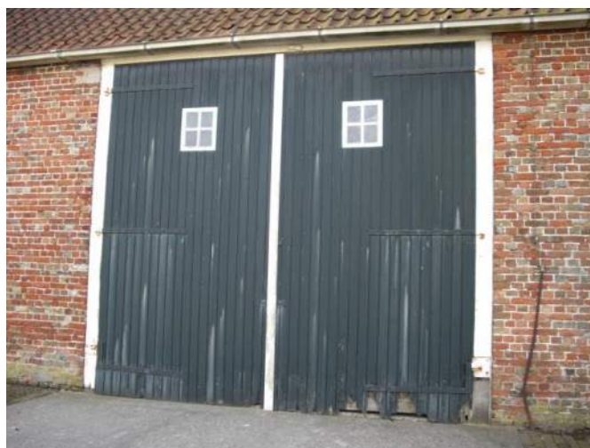
Vervijderen oude voegwerk en opnieuw voegen met schelpkalk
