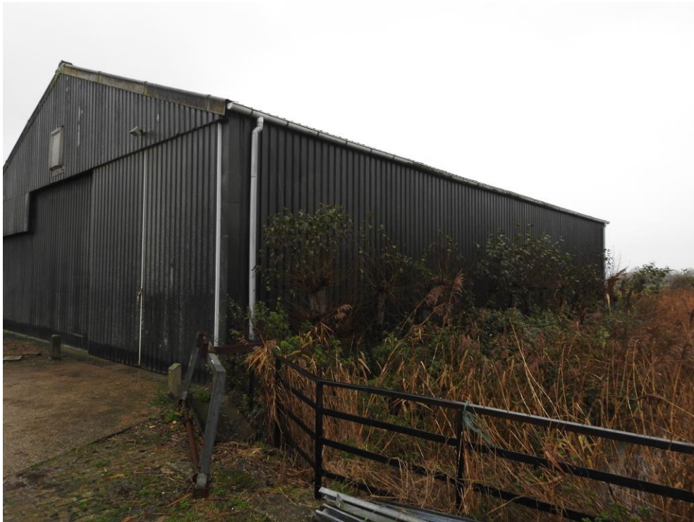
Foto 1. Plangebied, te slopen bebouwing.
