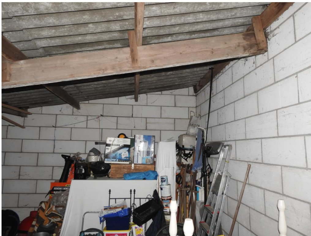
Foto 4. Te slopen bebouwing.
