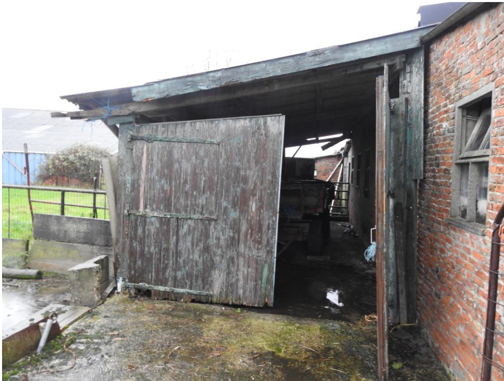
Foto 2. Plangebied, te slopen bebouwing.
