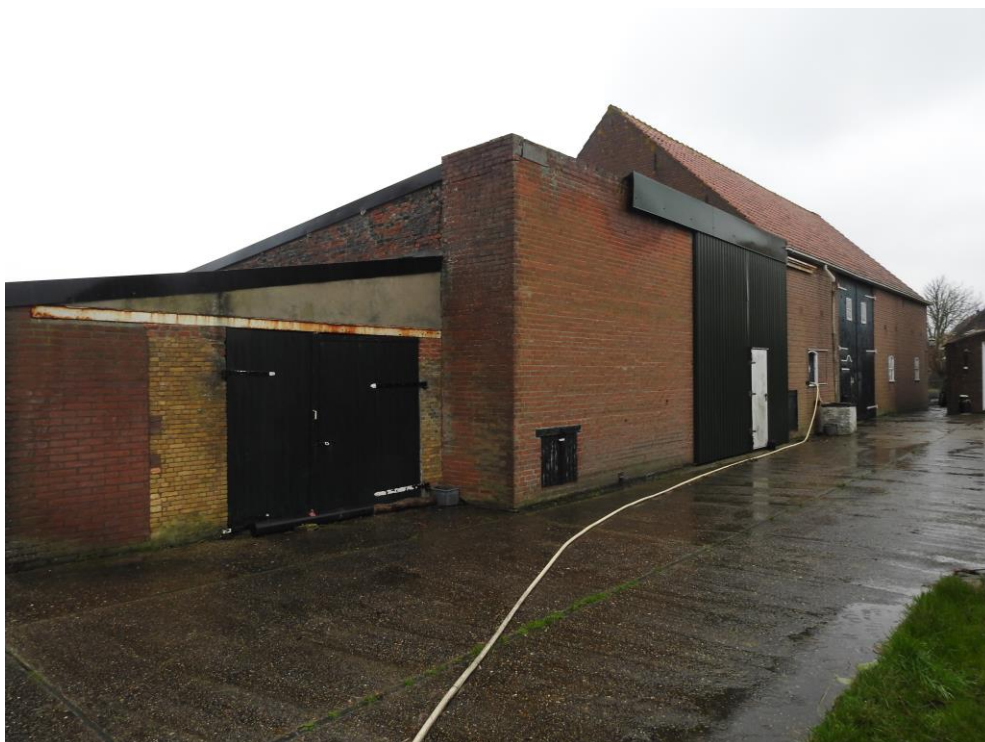
Foto 3. Te slopen bebouwing.
