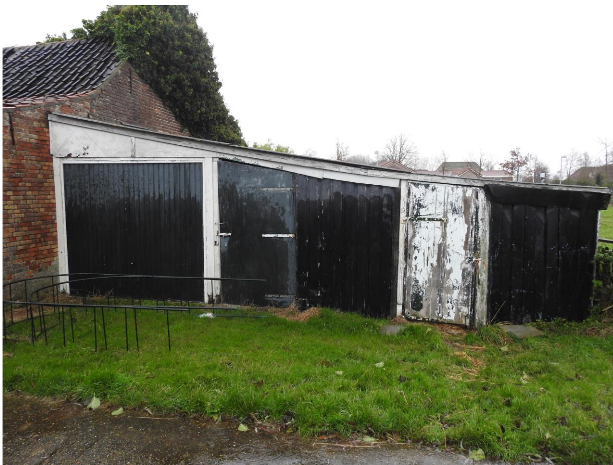
Foto 5. Te slopen bebouwing.
