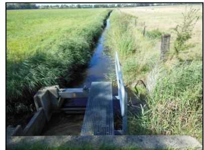
Figuur 5. Watergang, oostelijk deel onderzoekslocatie.
