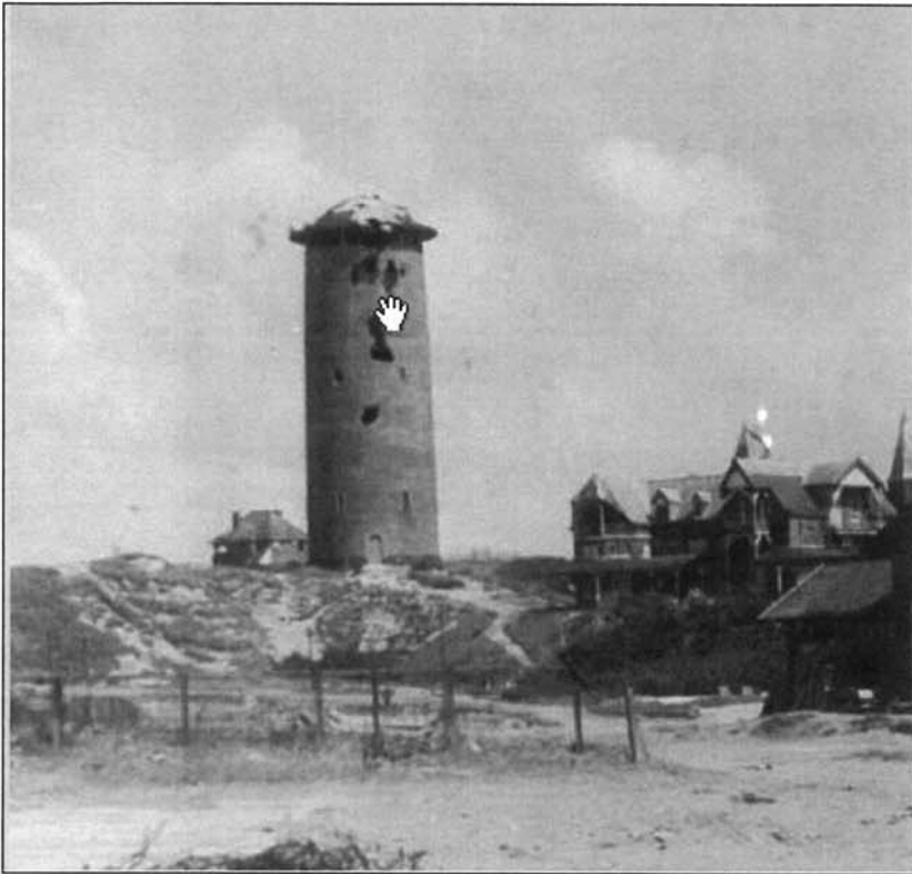
Watertoren Domburg – Duidelijk zichtbaar is de oorlogsschade van de toren en het hoogte verschil van de voet toren met de rest omgeving.
