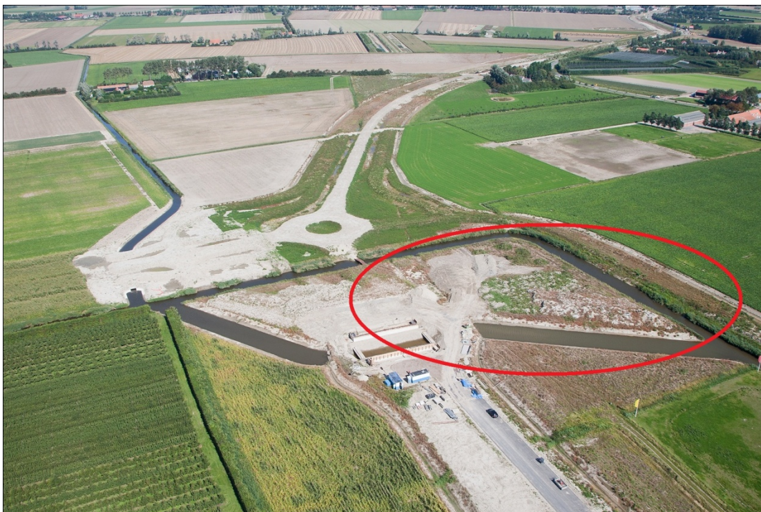
Figuur 2.4. Luchtfoto met locatie van de waterberging
