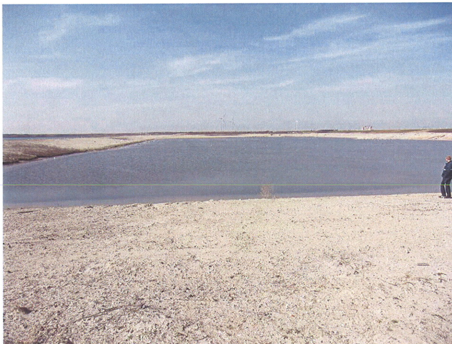
Figuur 4. Ontgraven zanddepot in de eindfase.
