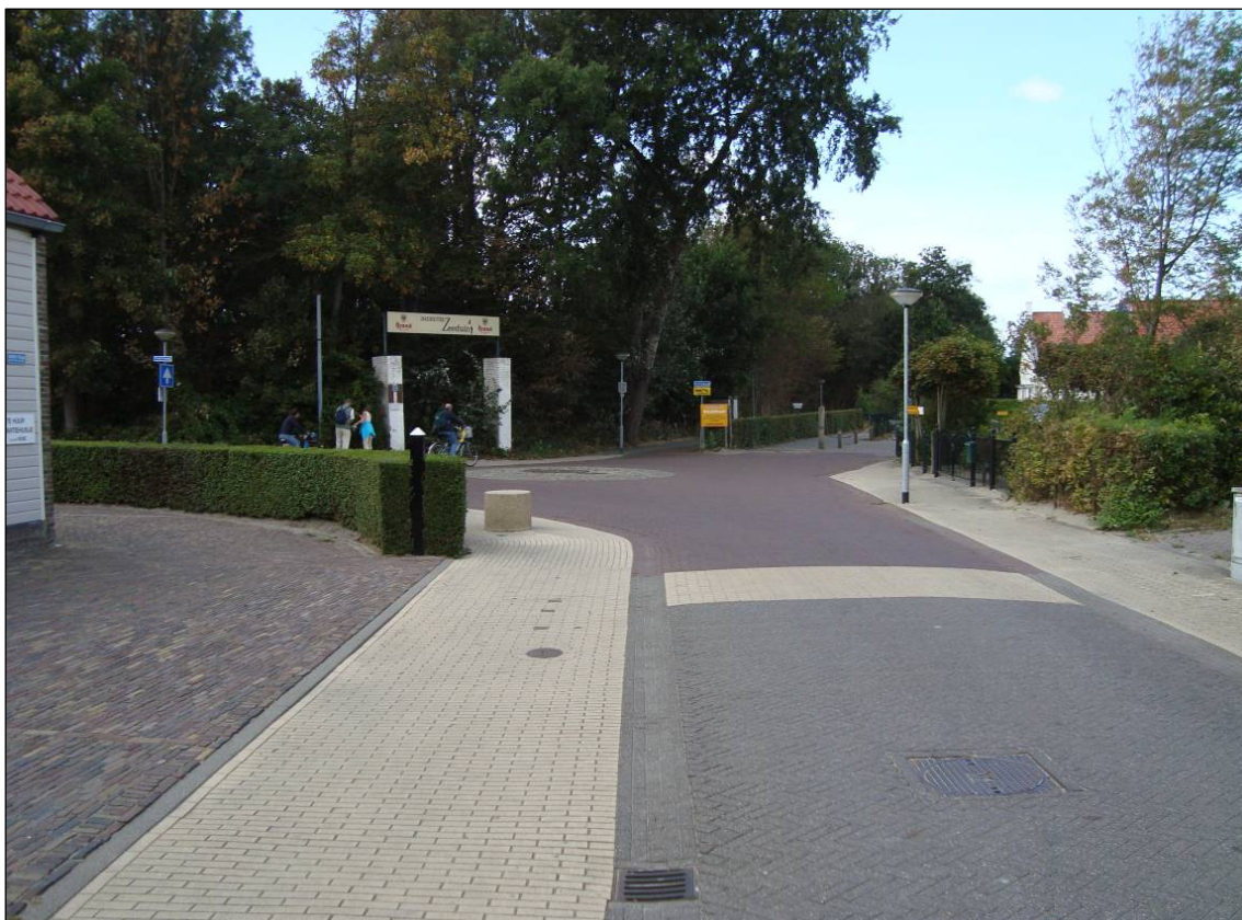
Figuur 2.8. Straatbeeld Kaapduinseweg (tussen huisnummer 11 en plein)
