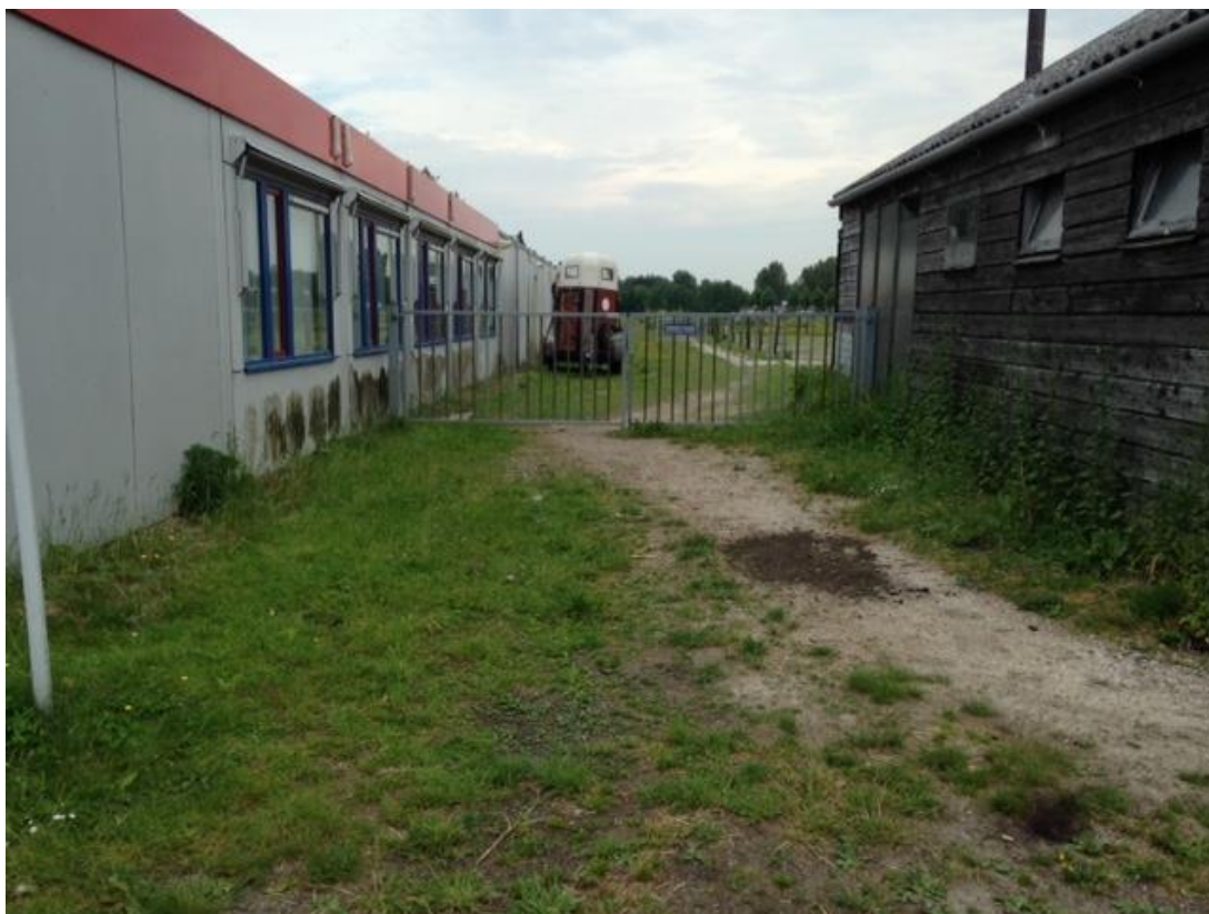
Foto 1. Locatie tpv boring 701 met de puinhoudende toplaag.
