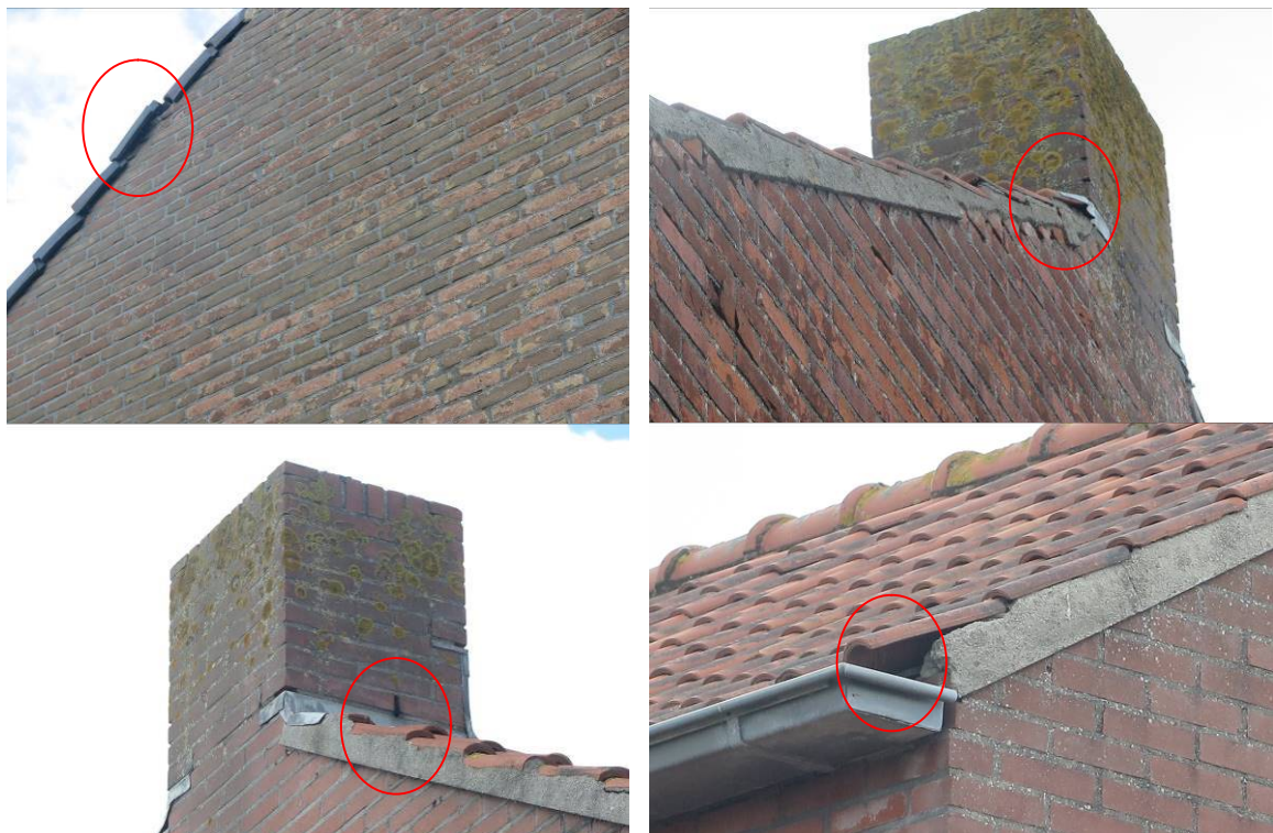
Figuur 4. Potentiele verblijfplaatsen van vleermuizen.
