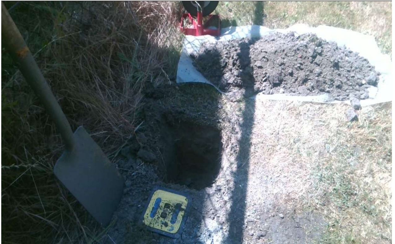
Foto 3: Asbest gat (30x30x50cm) naast peilbuis 2
