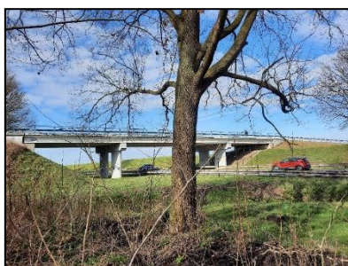
Figuur 10. Overzichtsfoto van viaduct over de N286.
