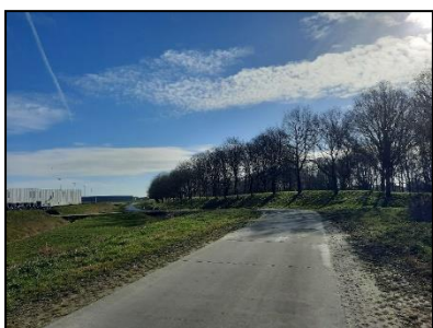
Figuur 9. Overzichtsfoto van de dijk langs de N286.
