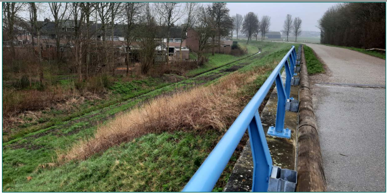
Foto vanuit het viaduct richting de zuidkant van de N286. De locatie voor de fietstunnel is hier te zien.
