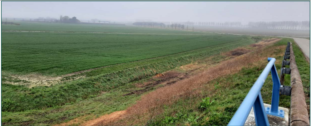
Foto vanuit het viaduct richting de westelijk gelegen locatie van de waterpartij.
