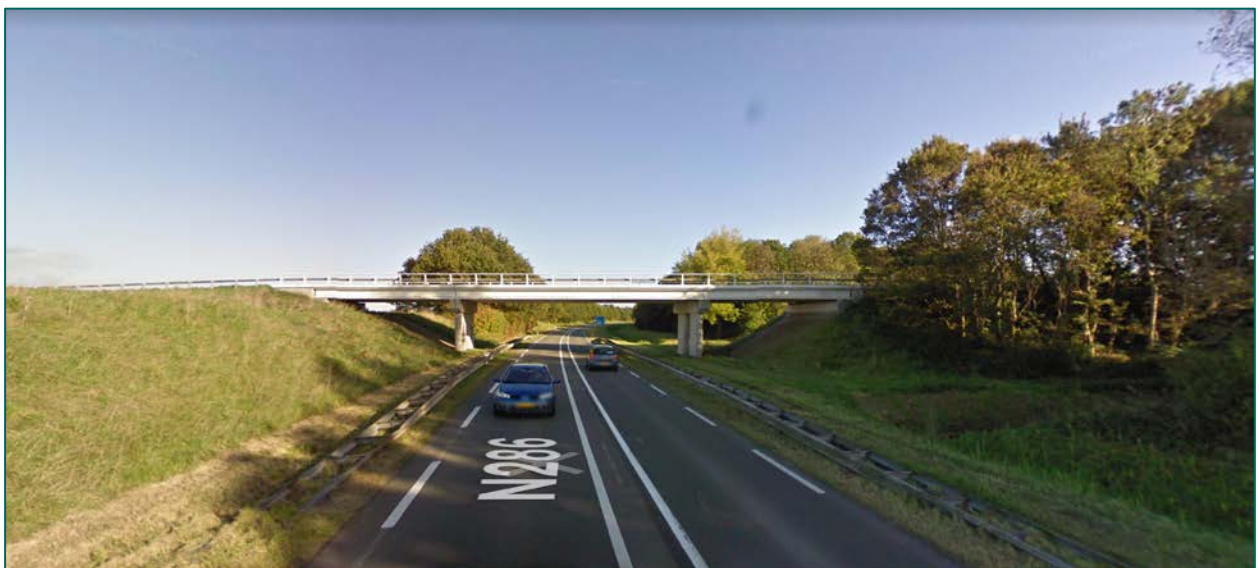
Figuur 11. Huidige situatie rondom de N286 en het viaduct, gezien vanuit west naar oost (Bron: Google streetview).
