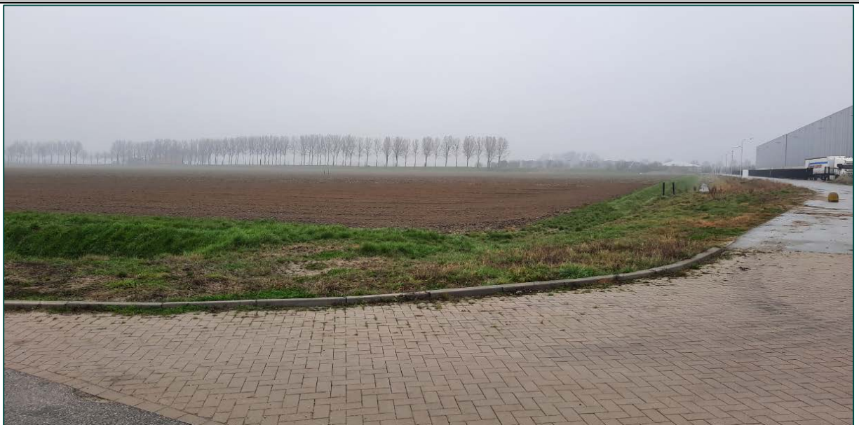
Foto vanuit de kruising Akkerweg/ Molenvlietsedijk richting waar het nieuw wegtracé en fietspad wordt aangelegd.
