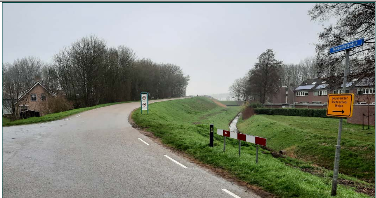
Foto richting het viaduct vanuit het zuiden. Rechts van het viaduct wordt de fietstunnel gerealiseerd, nadat het viaduct is verwijderd.
