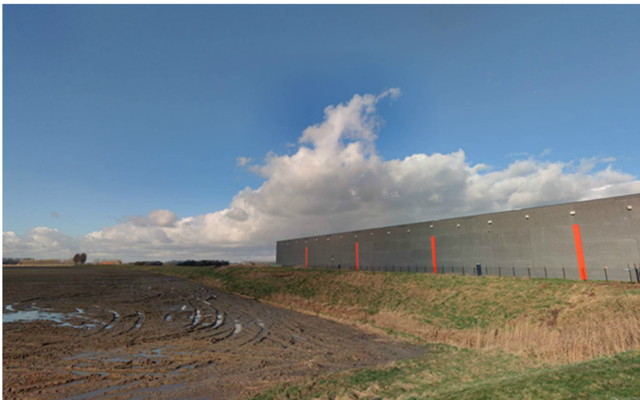
Afbeelding B2.10 Het af te graven dijkgedeelte met daarachter de bedrijfsbebouwing van Alternate (kijkrichting noord)
