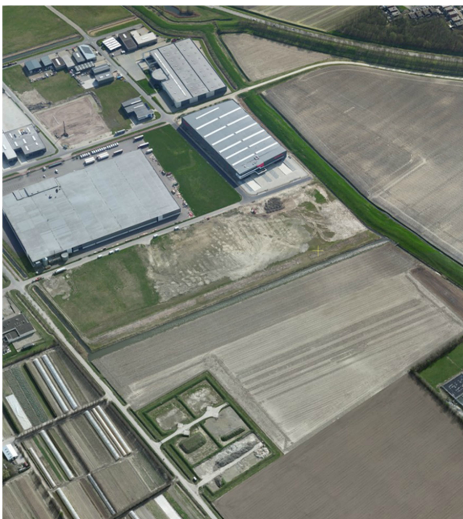
Afbeelding B2.7 Het af te graven dijkgedeelte (kijkrichting zuid)
