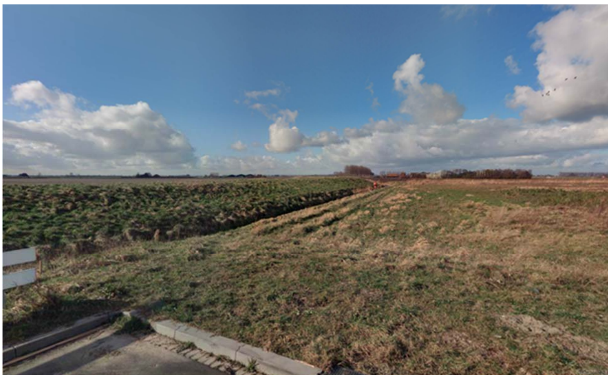
Afbeelding B2.9 Het af te graven dijkgedeelte gezien vanaf Welgelegen II (kijkrichting noord)
