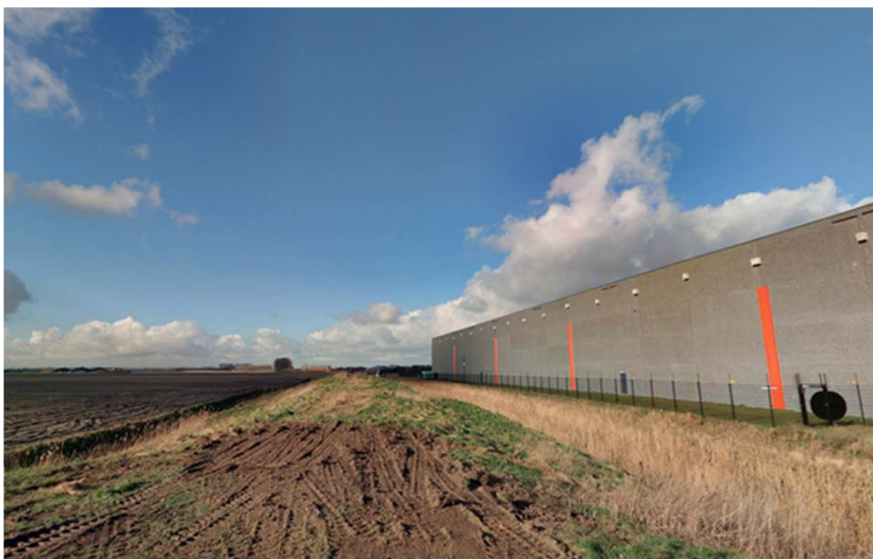
Afbeelding B2.11 Het af te graven dijkgedeelte met daarachter de bedrijfsbebouwing van Alternate (kijkrichting noord)
