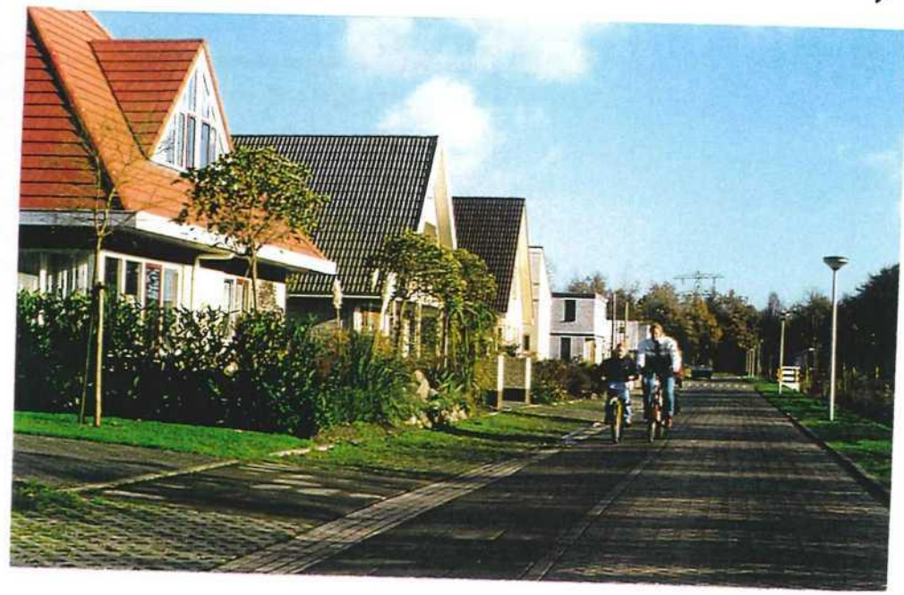
voedte molgoot t.b.v. afvoer regenwater
