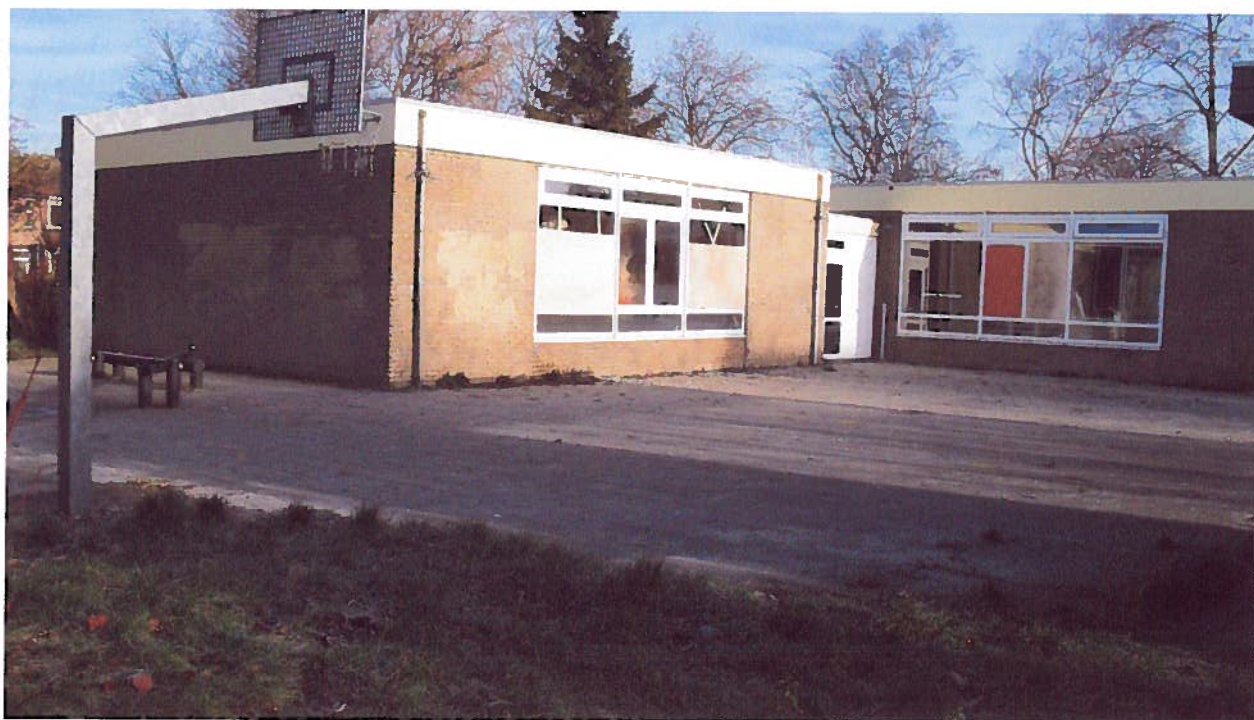
Foto 2: foto is genomen vanuit het zuidwesten van de onderzoekslocatie op het schoolplein.
