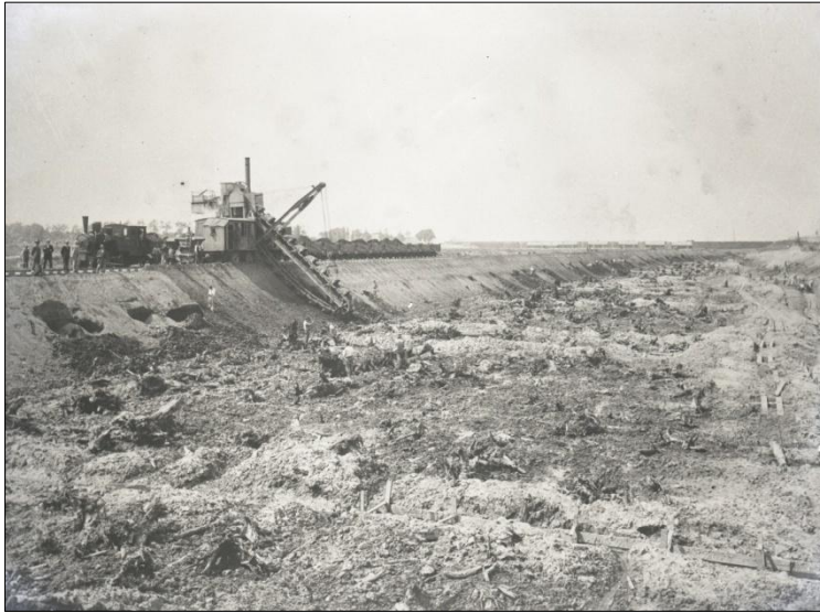
Afbeelding 12A Resten van het oerbos [veenbos], aangetroffen bij het uitgraven van de Schutsluis te Terneuzen in 1902. Bron: Archief Rijkswaterstaat.
