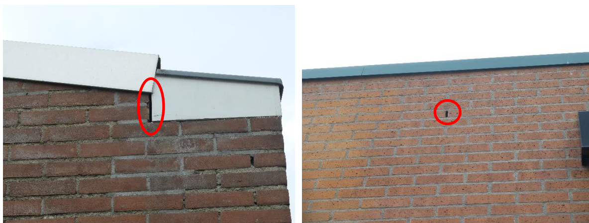
Figuur 5 Openingen langs de daklijsten en open stootvoegen
