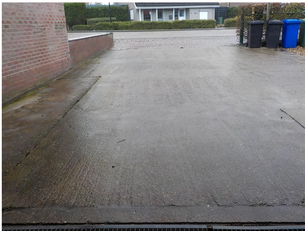
Foto 3: Betonbestrating voor de timmerwerkplaats
