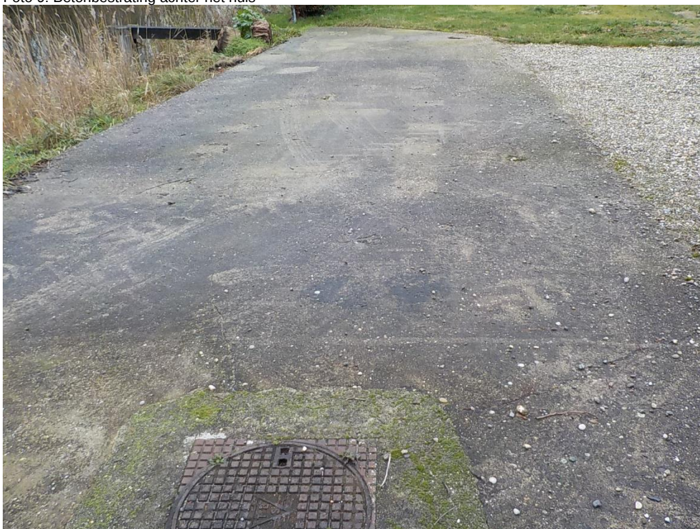
Foto 10: Betonbestrating achter op het terrein met bijbehorende putdeksel (riool)
