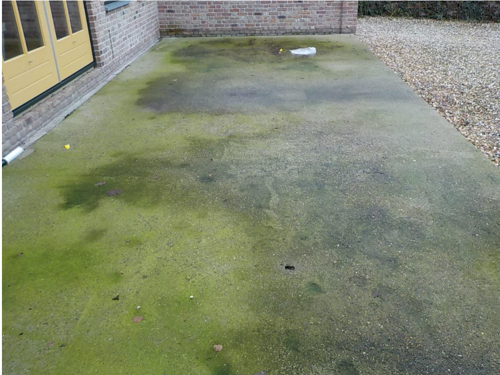
Foto 9: Betonbestrating achter het huis
