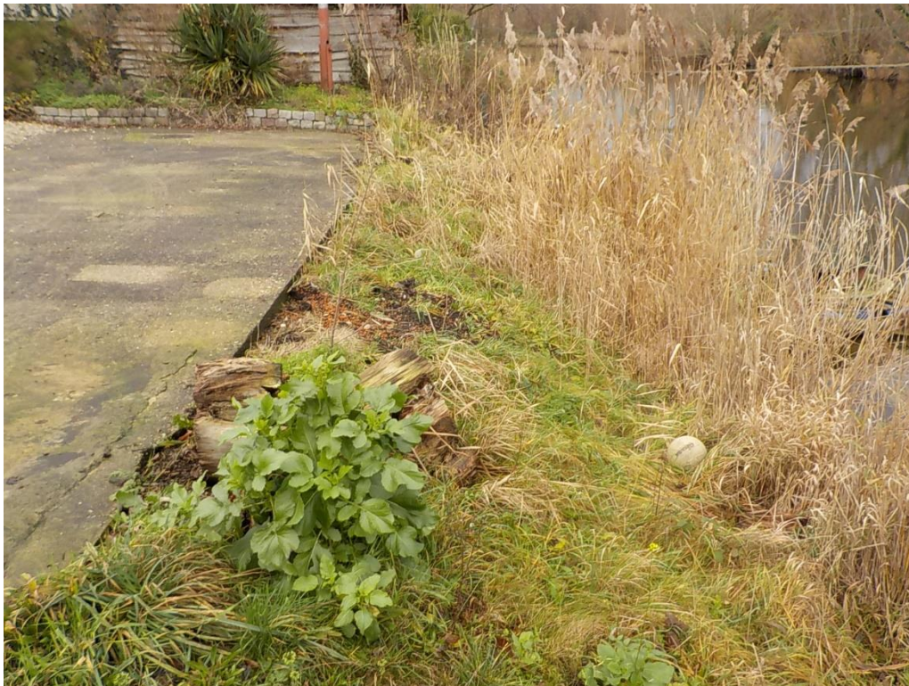
Foto 11: Einde van het terrein tot talud
