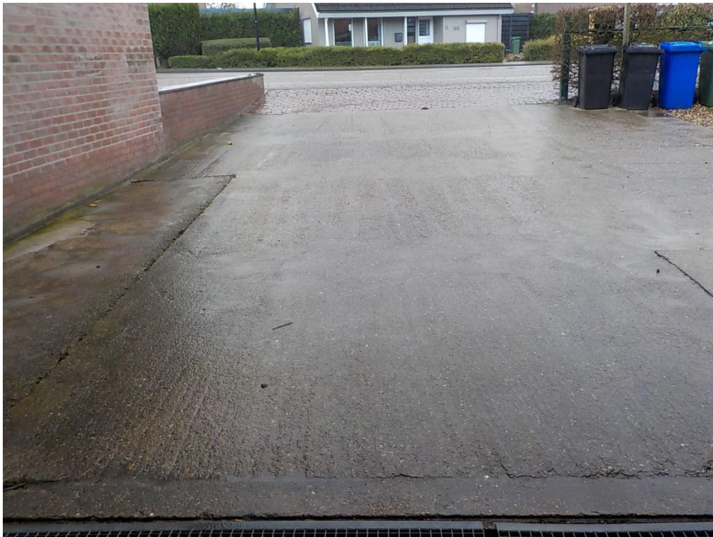
Foto 4: Betonbestrating voor de timmerwerkplaats
