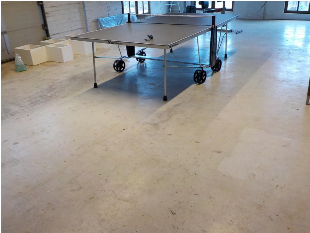
Foto 5: Betonvloer in de timmerwerkplaats
