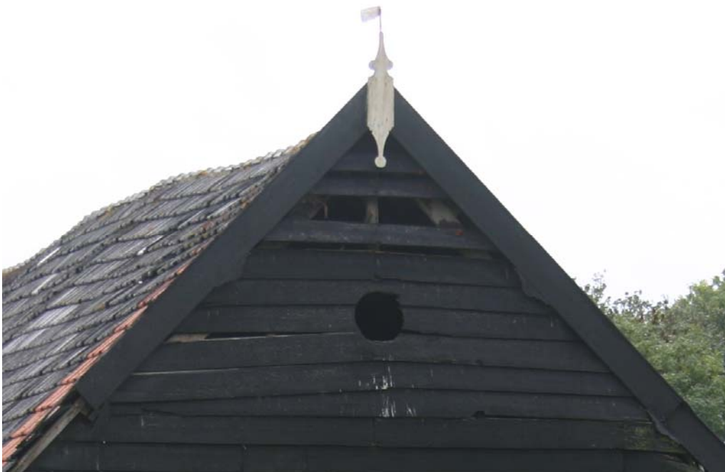
Figuur 4.2.2. Uilengat in schuur aan de Pootersdijk 3 (met uitwerpselen eronder)
