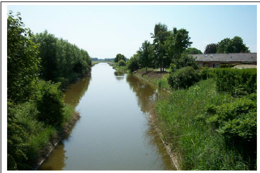
Foto 4. Zicht vanaf de Havenstraat over het uitwateringskanaal.
