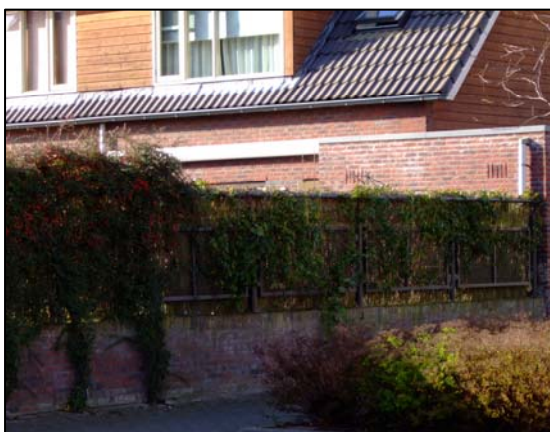
Deels opgemetselde erfafscheidingen met een groene of houten invulling.
