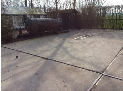
Figuur 9: Bovengrondse dieselolietank met tank- en/of wasplaats
