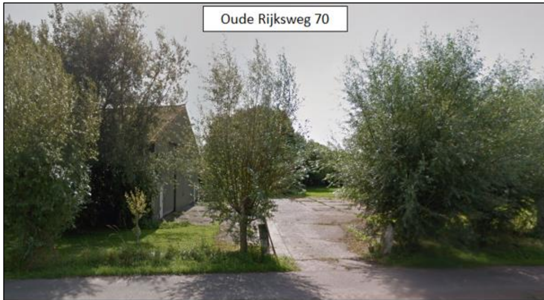
Afbeelding 5 Bestaande agrarische bedrijfsloods Oude Rijksweg 70
