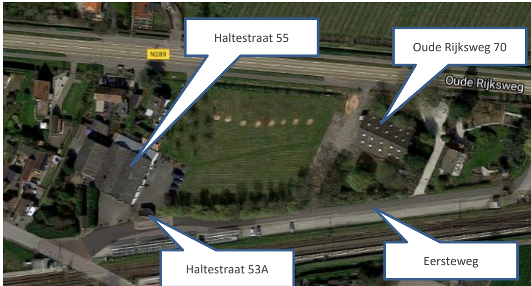
Afbeelding 3 Bestaande bebouwing binnen plangebied
