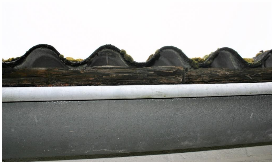
Figuur 4.4.2. De ruimtes onder het golfplaten dak bevatten geen (oud) nestmateriaal, braakballen, eierschalen, etc. Vogelnesten zijn hier afwezig en voor vleermuizen zijn de openingen te tochtig.
